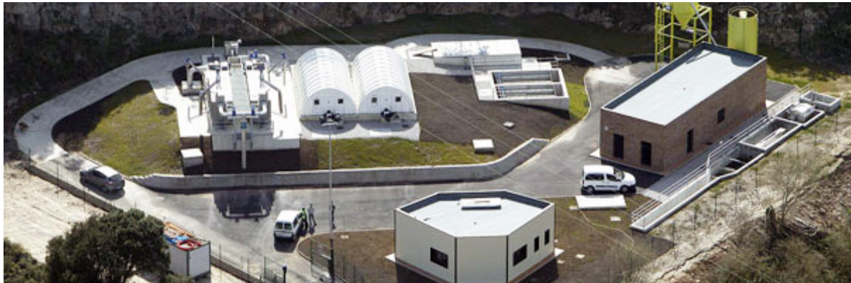
Figura 1. Vista aérea de la EDAR de La Franca.
