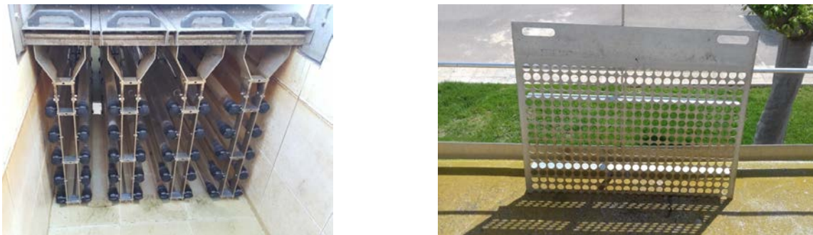
Figura 3. Banco de lámparas del canal UV (izquierda) y deflector perforado (derecha).
