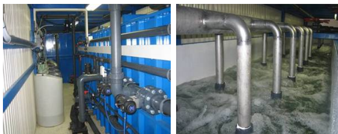
Figura 5.- Vista del interior del Contenedor y Depósito de Membranas de UF durante la aireación.
