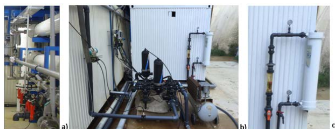
Figura 9.- Filtro de cartucho empleado en la plataforma experimental a), Filtro de anillas automático b) y Filtro de cartuchos c)
