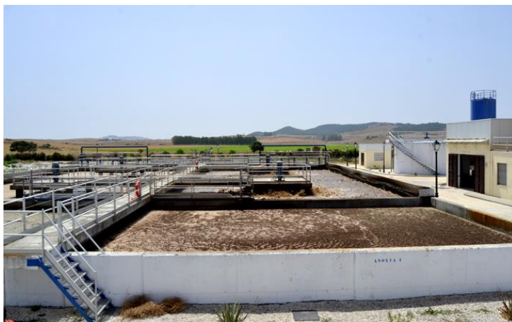
Figura 1. Reactor biológico EDAR Medina Sidonia. Foto cedida por Medina Global.
